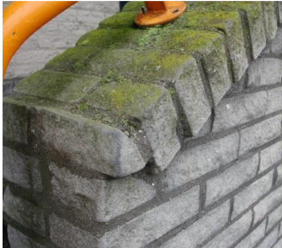
Algen en mossen op een rollaag (3.4.a)
