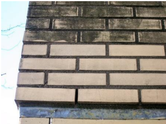
Atmosferisch vuil op een gladde, dichte steen (3.3.b)
