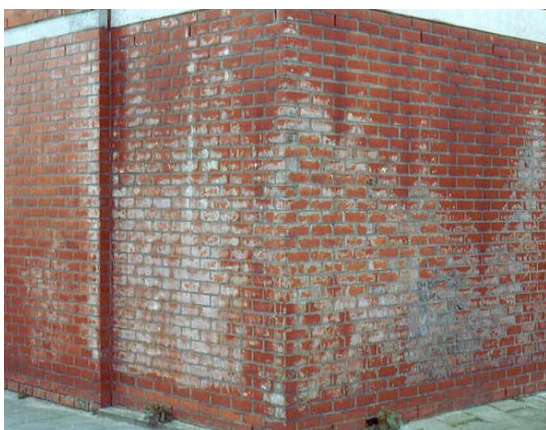
Resten van een anti graffitty systeem (3.7)
