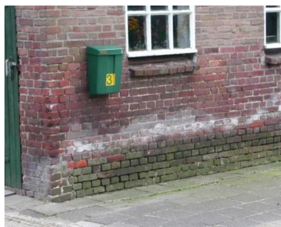
Uitbloei van nitraat op een stal (3.1.a)
