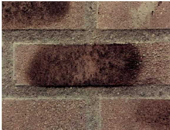
Mangaanroest op een strengperssteen (3.5.c)
