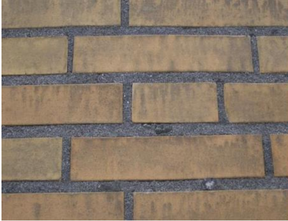
Neerslag van losse ijzerdeeltjes en organische Deeltjes (3.3, 3.5.a)
