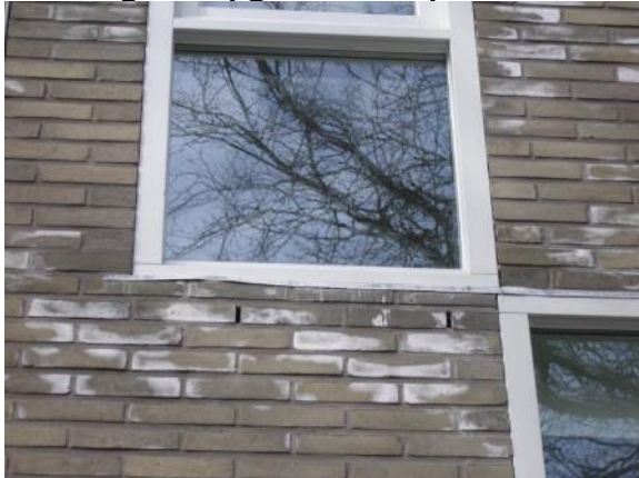
Uitbloei van oplosbare zouten (3.1.b)
