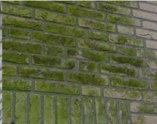
Alggroei door ondeskundig reinigen met een middel op basis van fosfor- of zoutzuur (3.4.a)
